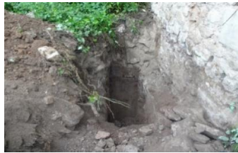
Şəkil 2. Binanın xaricində qazılmış şurf
