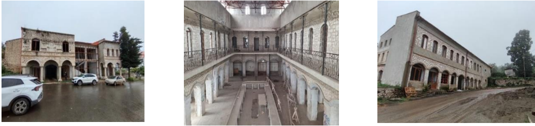
Şəkil 1. Karvansaray binasının bərpadan əvvəl ümumi görünüşü
