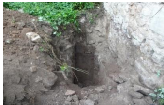
Şəkil 2. Binanın xaricində qazılmış şurf
