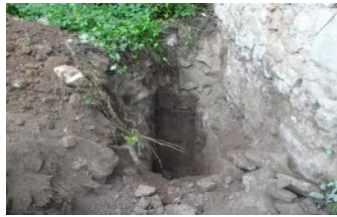
Şəkil 2. Binanın xaricində qazılmış şurf
