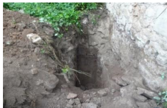
Şəkil 2. Binanın xaricində qazılmış şurf
