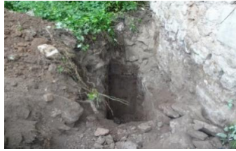
Şəkil 2. Binanın xaricində qazılmış şurf
