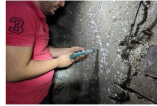
Şəkil 3. Betonun möhkəmliyinin “Şmidt hammer” sklerometri vasitəsilə təyini
